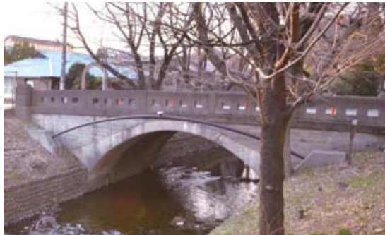
現存する最古の道路れんがアーチ橋の日光橋
