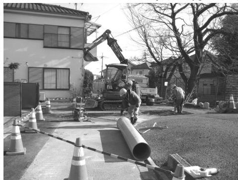
熊川 888 番地付近の雨水対策工事
